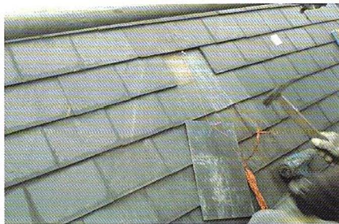
屋根スレート補修
